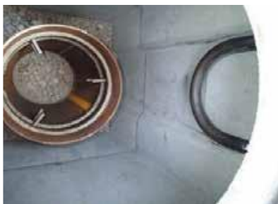
Внутренняя поверхность трапециевидного пространства
