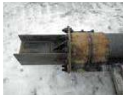
Установка арматуры с помощью затягивания болтов
