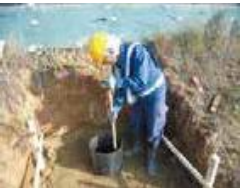
Уборка остаточной земли в стальных трубчатых сваях
