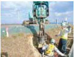
Ослабление болтов, снятие арматуры
