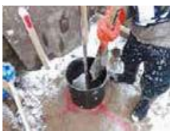
Устранение остаточной почвы в сваях
