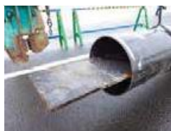
Сварка зажимной плиты
