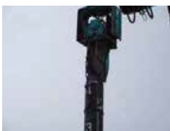
Поднятие объекта с помощью плиты
