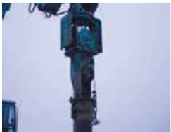
Поднятие объекта с помощью арматуры
