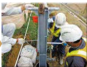
Корректировка позиции опор
