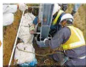
Затяжка регулирующего болта
