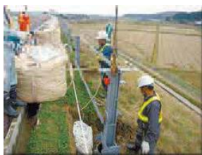
Внутри стальных трубчатых свай устанавливаются опоры
