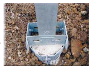
После установки производится заливка бетоном.
