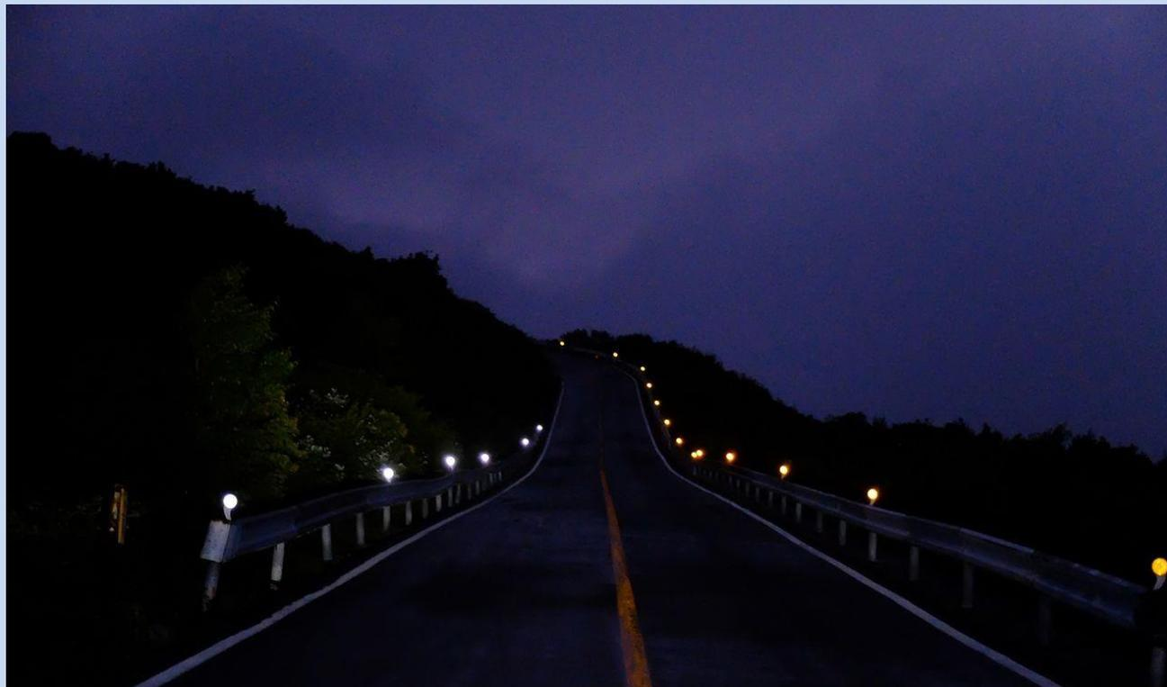
В верхней части стойки (ок.  $H=0.9\text{м}$ ) размещен модуль, оборудованный солнечной батареей и источником света, зрительная ориентация осуществляется путем самопроизвольного свечения.
