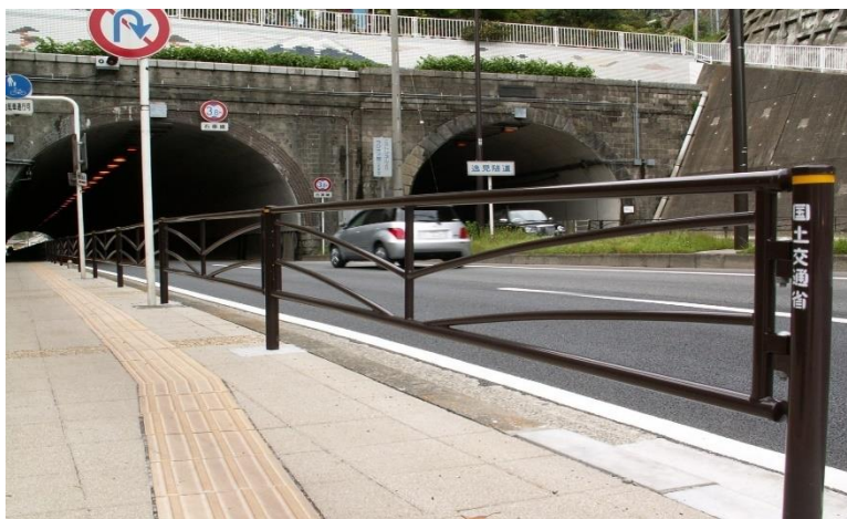
Р-класс (защитное ограждение для пешеходов и велосипедистов)
