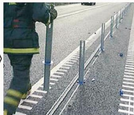
②支柱撤去
