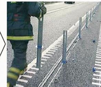
②支柱撤去
