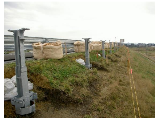
Установка столбов нижней части
