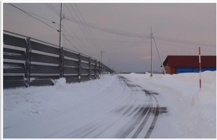
Состояние местности около снегосдувающего ограждения
