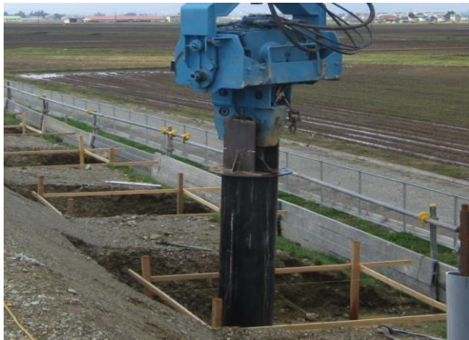
Забивка стальных труб
