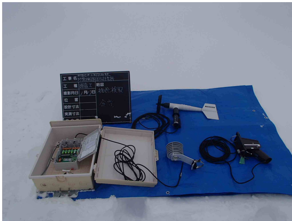
写真 2-2-1 機器検収 (全景)
