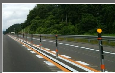
車両飛び出しは防止できるが視認性が劣るワイヤーロープ式防護柵
