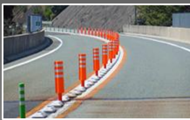
オレンジ色で視認性は良いが、車両の飛び出しが発生するラバーボール
