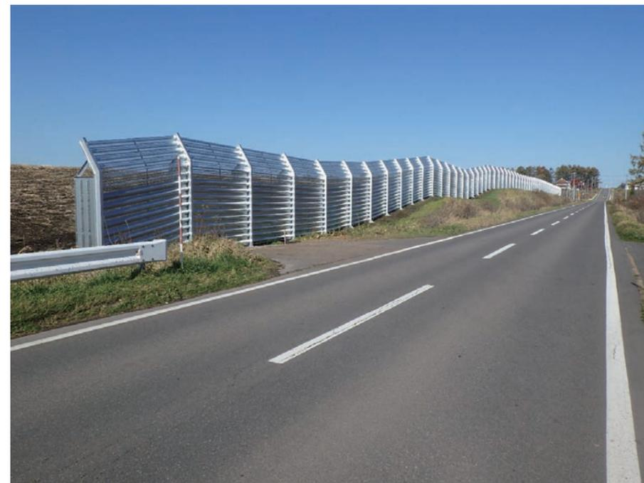
柵施工区間では、取付道路部・縦断勾配等の道路及び地形条件に合わせた柵の設計に取り組み、柵の一連性を保つことで柵に設けられる開口部や道路地形状況から風雪が道路上に流れ込み発生する吹き溜まりを防止することで、通行する車両等の交通の安全を確保します。
