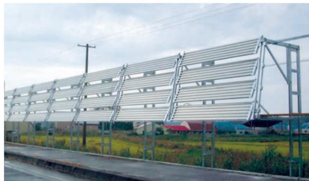
吹払柵が設置されている場所に多く見受けられるのが、除雪により押し寄せられた雪塊が下部間隙を塞いでいるケースです。吹払柵はこの下部間隙が確保されていることが非常に重要です。この問題を解決するために考案された本製品は、下部間隙に溜まった雪をグレーダーによりかき出しながら除雪することが可能となり、常に安定した吹払効果が期待できます。夏期間は防雪板を収納し、さらに、防雪板を取り付けている支柱は道路から離れて収納されますので、ドライバーへの圧迫感を軽減でき、安全走行が確保できます。
