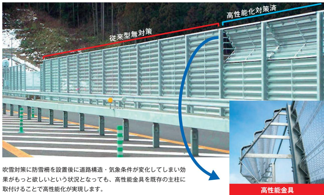
吹雪対策に防雪柵を設置後に道路構造・気象条件が変化してしまい効果をもっと欲しいという状況となっても、高性能金具を既存の支柱に取付けることで高性能化が実現します。
