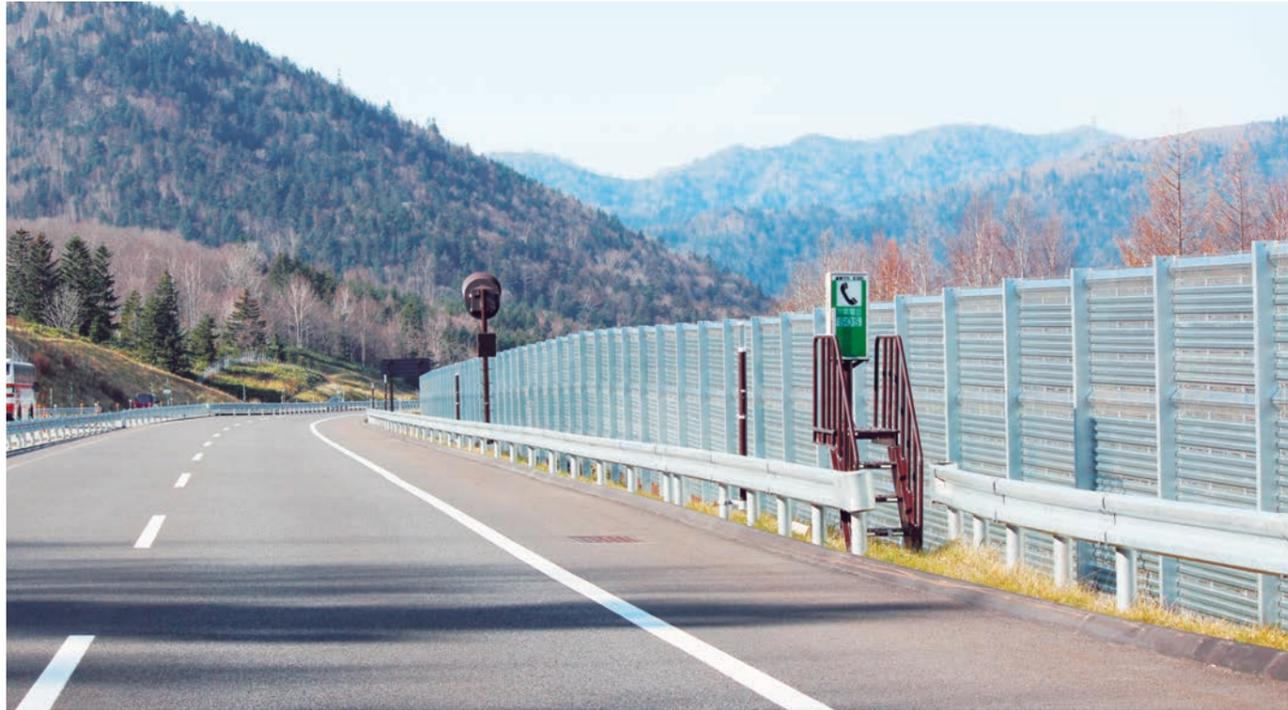
自立式直立吹止柵は1年を通して設置する形式の防雪柵です。地吹雪を抑え、柵の風上側により多くの雪を堆積させる効果があります。
