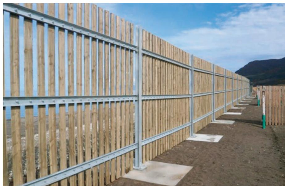
鋼製防風板の代わりに、「間伐材」を使用した製品です。自然環境にも調和した木の感触は、鋼製の商品では表現できないやさしさを表現できます。
