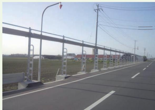
自立式板巻上型吹払柵は、農道における農業機械の出入りを最優先。さらに、防雪柵による日陰対策として活用されています。防雪板はウインチによる巻上・下機構を導入。維持管理も容易に行えます。
