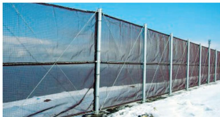
柵全体に空隙率 50%の防塵用樹脂ネットを用いて風上からの風速を減風し、塵や埃の移動を防止します。
