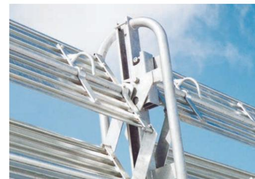
防雪柵の維持管理作業は秋や春に集中します。この時期は季節風が吹き荒れる事も多く、作業中の安全性を最優先させなければなりません。本製品は、強風時でも独自のガイド機構により防雪板や部品の脱落が無く、厳しい条件下でも極めて安全に作業が行えます。
