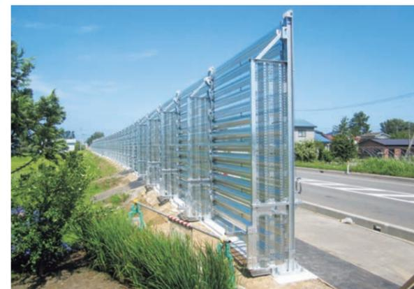
防雪柵の端部数スパンに整風板を取付けることにより、防雪柵方向に流れる風を抑制することが可能です。そのため、立地条件によりどうしても防雪柵を設けることができない開口部や、防雪柵の端部に発生する局所的に激しい視程障害を緩和することができます。
