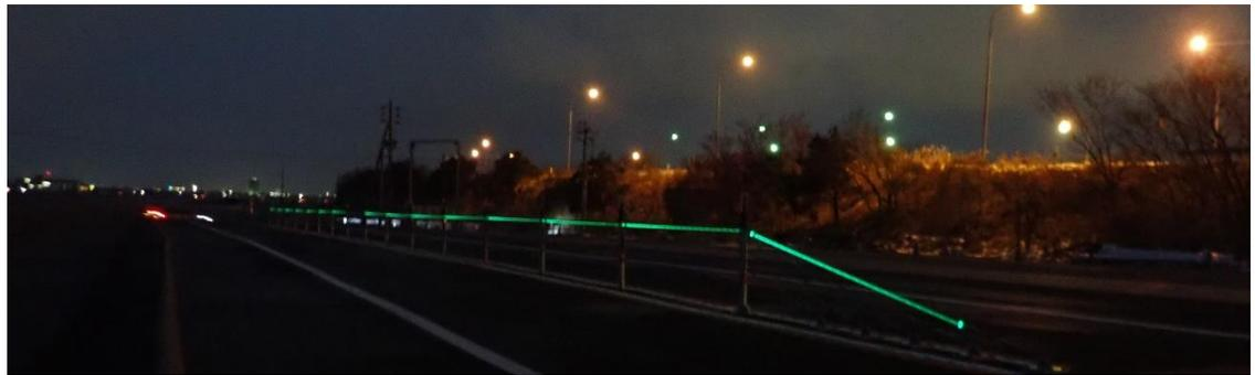
ワイヤーロープ式防護柵は高速道路の暫定二車線区間での車両の正面衝突事故を防ぐもので、2018年6月に国土交通省が本格設置することを発表しました。現在整備が進められており、対向車線への飛び出しは激減し死亡事故はゼロとなりましたが、ワイヤーロープへの車両の衝突事故が多発し、通行止めが急増しています。このため、弊社は本製品でさらなる安全性向上を図りたいと考えております。
