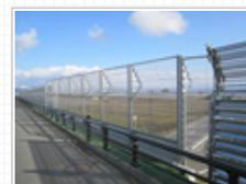
ボックスカルバート部の側壁部にも防雪柵を取付けることで連続した設置が可能となり、防雪柵の端部から吹き込む地吹雪で局所的な吹溜の発生を抑止することができます。更にボックス部はブラックアイスバーンになるケースが多く、ポリカ板を使用する事で日陰にならないので凍結防止にも役立ち、あらゆる用途にて使用可能です。
