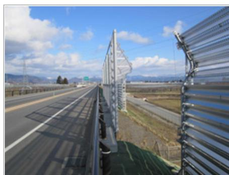
ポリカ板には台形タイプとフラットタイプがあり、台形タイプは許容応力内であればそのまま使用でき、フラットタイプはパネル構造となり枠組が必要で、ポリカの厚さはこのパネル寸法の大きさに変わります。ポリカ板は収縮が大きいので固定部にはクッション板が必要です。
