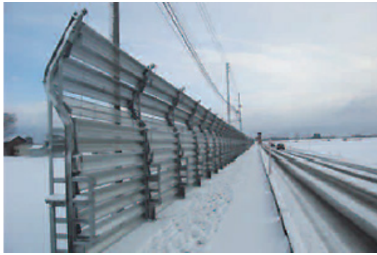
福島県会津若松建設事務所(会津若松三島線)
