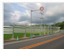
防雪板はアルミニウム押し出し成形により作られた製品で、軽量かつコンパクトな形状のため作業性に優れているのが特徴です。
