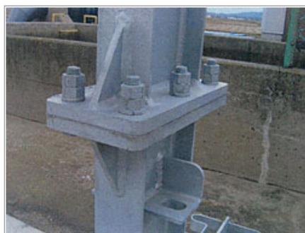
主柱のヒンジ部にある固定ボルトを取外し、主柱を折畳むことができます。
