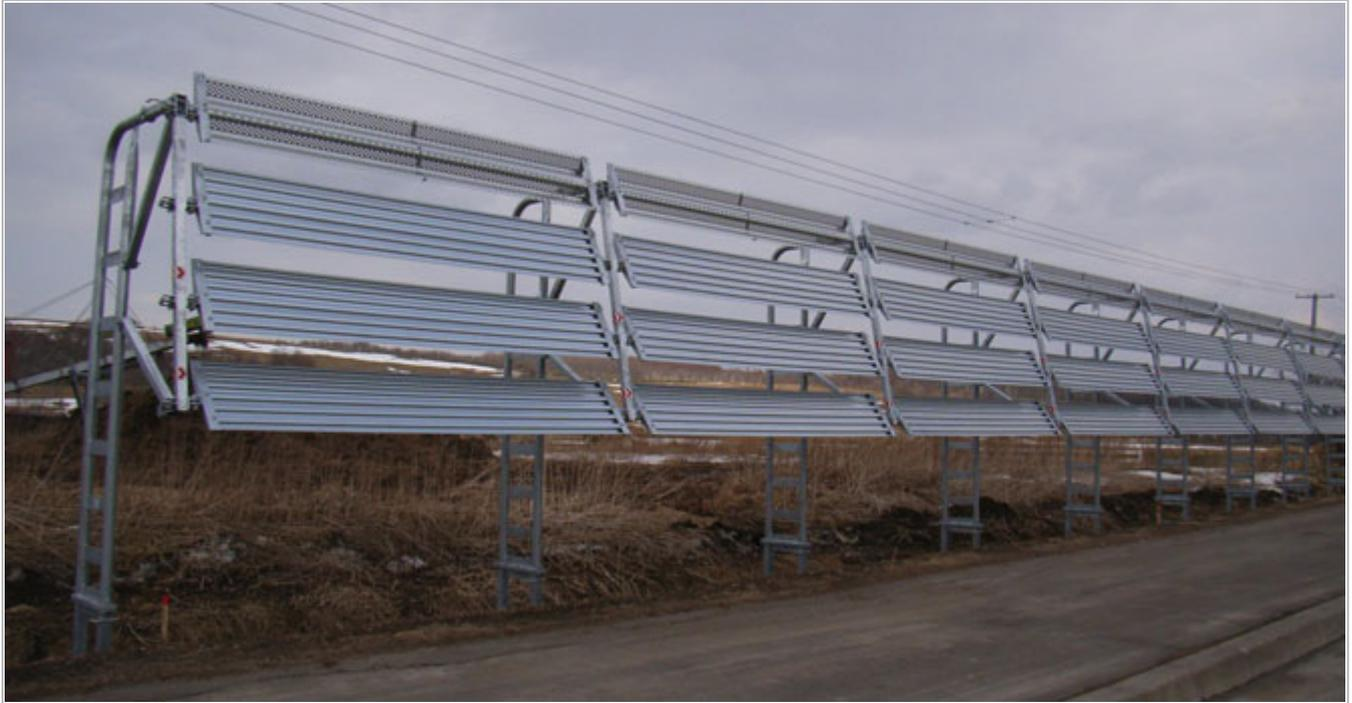
従来型の吹払柵がベースとなり、さらに各防雪板の角度がそれぞれ違った構造で吹払効率の向上を目指し開発した製品です。オーバーハング型の利点に吹払効率の向上をプラスした吹雪時の強い味方です。防雪板の角度は下から35°、30°、25°、20°の順になっています。
