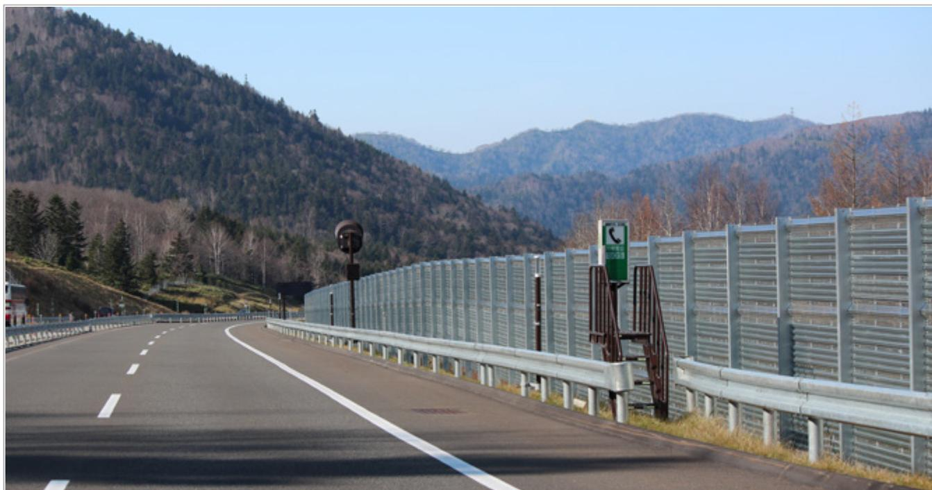
自立式直立吹止柵は1年を通して設置する形式の防雪柵です。地吹雪を抑え、柵の風上側により多くの雪を堆積させる効果があります。
