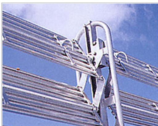
防雪板全数を、リンク機構で連結することにより、収納及建て込み時の操作性を向上しました。
