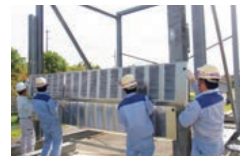
支柱前面取付けのスピード施工（人力施工が可能）
