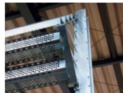
ユニットの取付けは、地組をしてボルト固定
