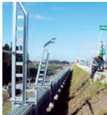
①電動油圧機器にて柱を建込
