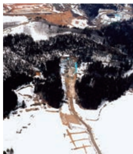
現地航空写真（工事前）
