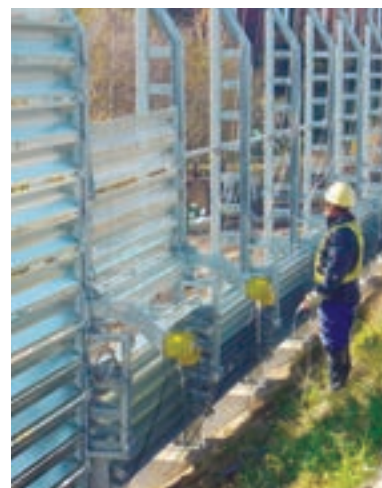
②電動ウインチにて防雪板を展開
