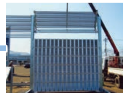
統一型遮音板は支柱（H 鋼）に落としこみ設置
