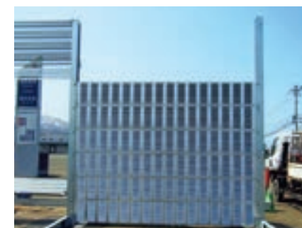
統一型遮音板は支柱（H 鋼）に落としこみ設置
