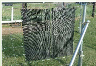
侵入防止柵への取付
