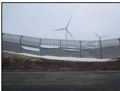
特に破損が大きい箇所へ
