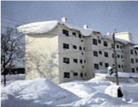
建物屋根の風上側からの風雪が障害物等の影響を受け風速が弱まり、吹き溜まりを作る現象で特にパラペット部分で乱流を作り、剥離渦が徐々に着雪され降雪と共に軒先からせり出します。次第に重力によってクラックを起こし落下すると重大な事故に繋がります。
