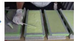
塗料注入 (全体的に均す)
