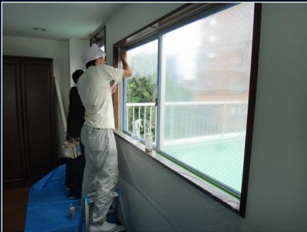
Memotong sinar UV dengan mengecat pada kaca
