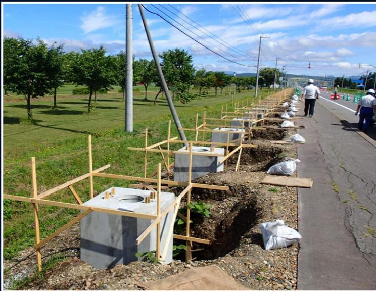
Blok pondasi beton untuk pagar salju tahan angin
