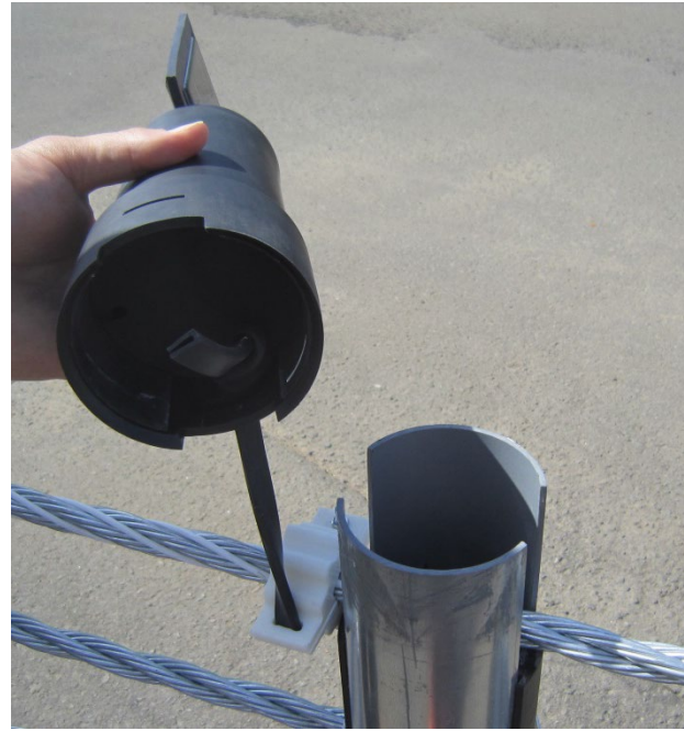
बिखरने से रोकने के लिए रबर कैप और रिकेन धुरी को रबर वायर से कनेक्ट करें
