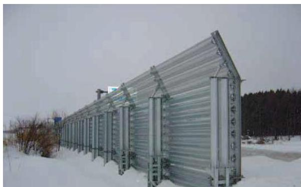
Вокруг щита для изменения направления ветра скапливается снег ⇒ Блокирование попадания снега к краям и скапливания снега в этой зоне
