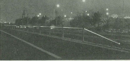
WR視線誘導標(全景)
