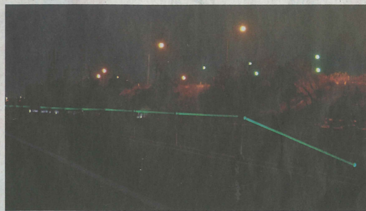
道路に設置された光るワイヤロープ (理研興業提供)
