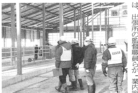
で各1現場を点検した。北清水田山地区の現場では、出張所の監督職員らが業内容について説明。安全掲示板や現場事務所内で書類点検を行ったあと、実際に現場を視察し、各種安全対策が施されていることを確認した。 鈴木所長は「これから高所での作業が続くと思うので、引き続き気を付けて作業してほしい」と呼びかけた。
