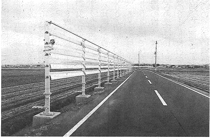
町道常盤中部線に設置された防雪柵(藤崎町)
