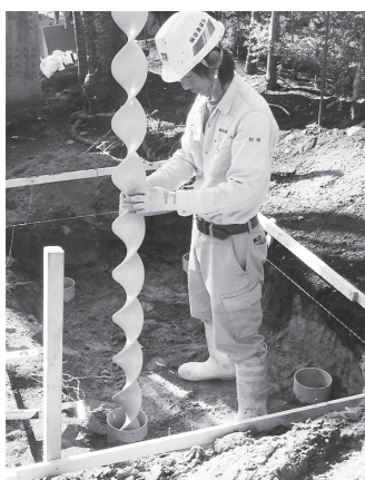
現場に「NSスパイク工法」が適用できる厳しい施工条件にも対応する
