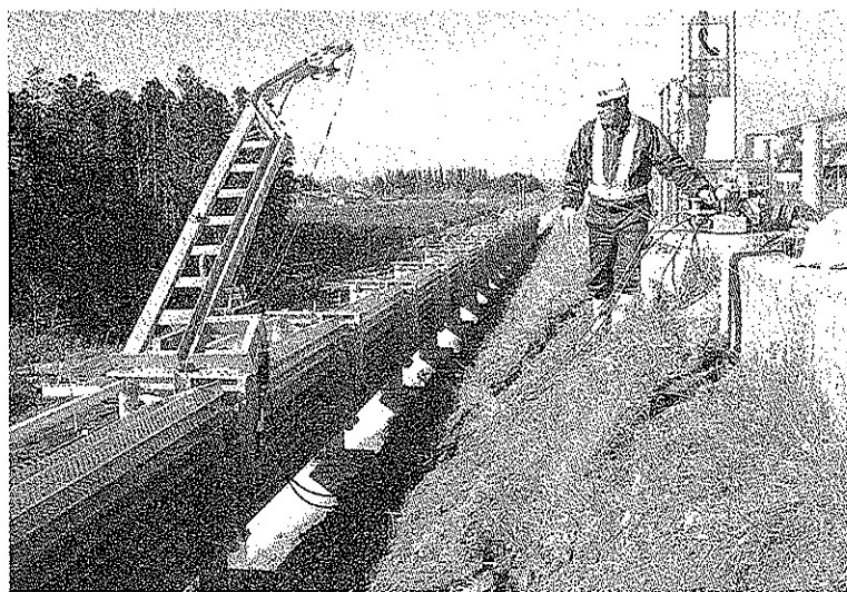
自動収納型高機能防雪柵設置現場
