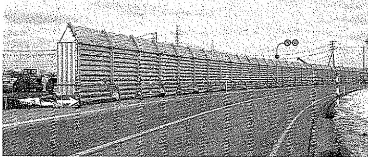
国交省東北地方整備局酒田河川国道事務所採用、設置された斜風対応型防雪柵
