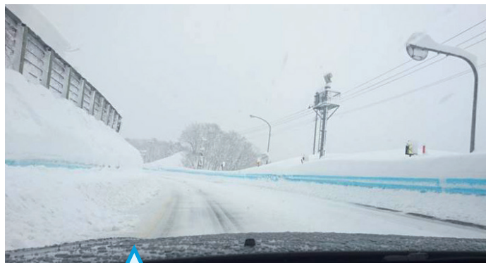
東北地方で実施されている路肩雪堤へのブルーラインの散布状況
